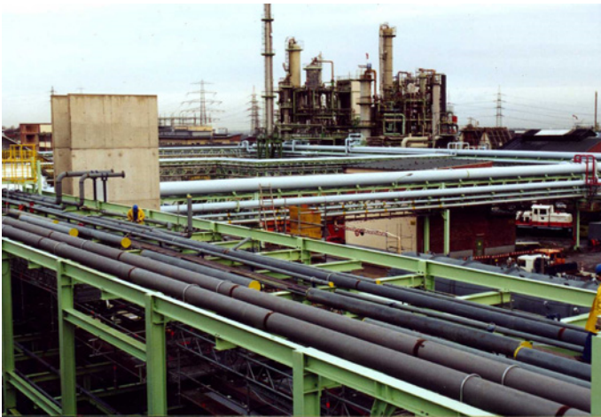
Bild 5.14 (Fortsetzung) Rohrbrücke. b) Rohrbrücke mit z. T. gedämmten Rohrleitungen [115], c) Leitungen auf Rohrbrücke mit noch unbehandelten Schweißnähten [115]
