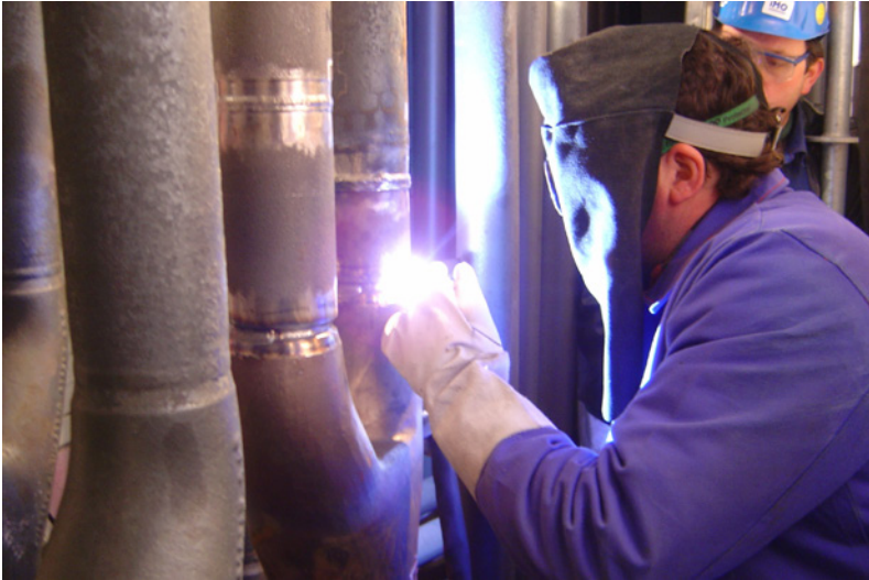
Bild 5.15 Schweißarbeiten an Rohren [115]
