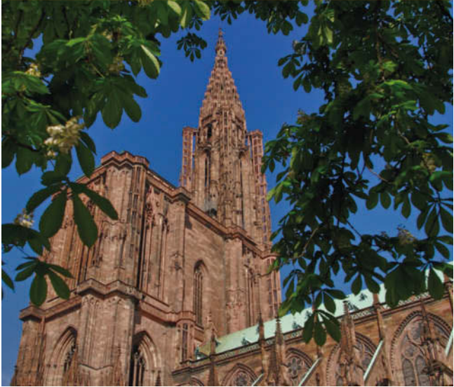
Das Münster wurde aus rosa Vogesensandstein erbaut, den die Sonne zum Leuchten bringt
