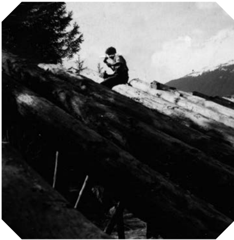
Oben: Josef Dornauer beim Löcher stemmen am oberen Ende der Rechenböcke für die Verbindungsstützen (Kopflanten) von Bock zu Bock in der Zillerklamm für die Trift, Frühjahr 1936. Nach der Trift. Beim Ausschneiden des Papier- und Brennholzes auf der alten Lände mit Kreissäge. Auf dem Bild Simon Gredler mit Kollegen.
