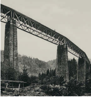
Kühnes Meisterwerk der Technik: Die Höllentalbahn überquert die Ravennaschlucht
